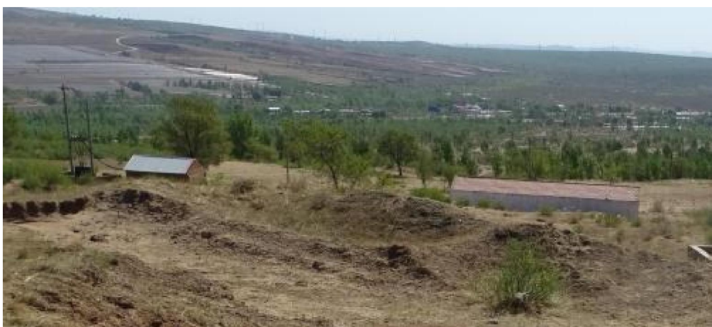
照片4-15 配电室（左）、仓库（右）
