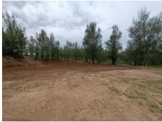
照片4-4 SJ4废石堆放场
