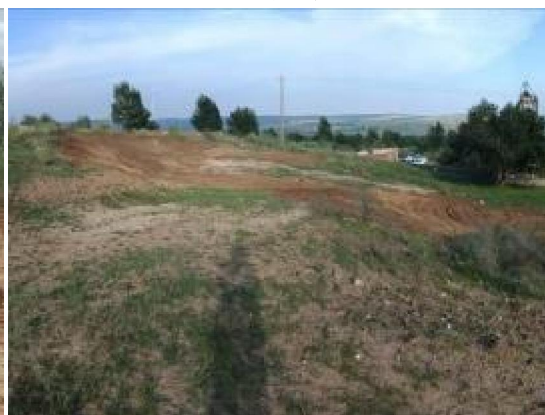
照片2- 17 2023年治理乱掘坑
