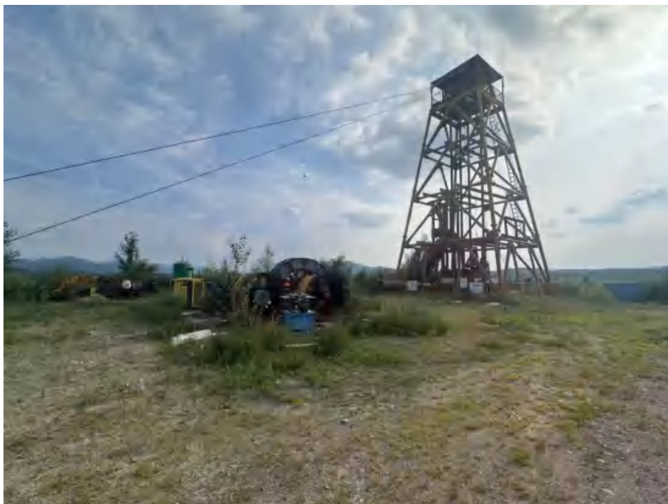
照片 4-2 SJ2 竖井工业场地
