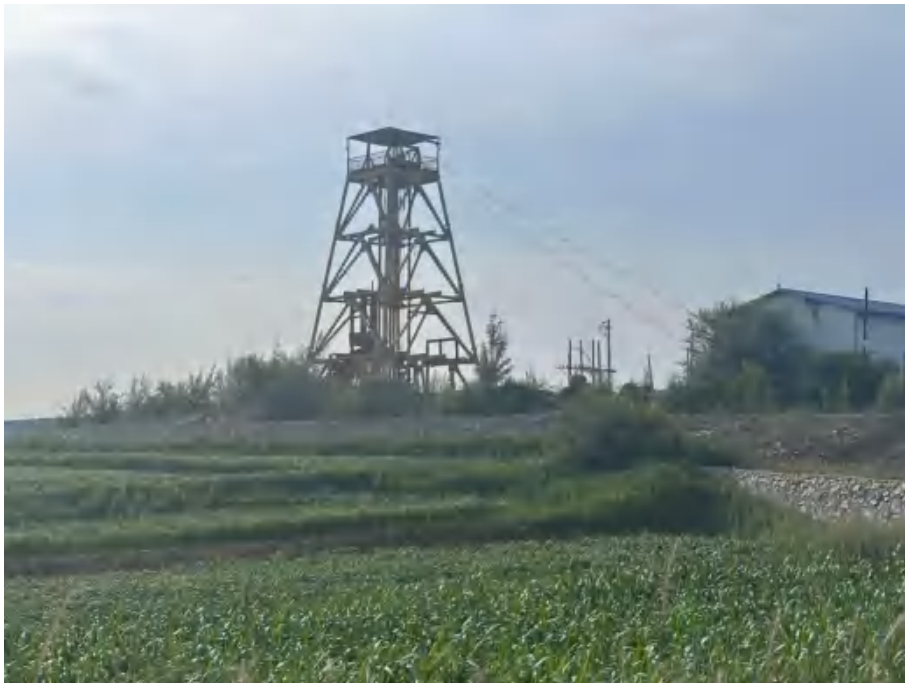
照片 4-1 SJ2 竖井工业场地
