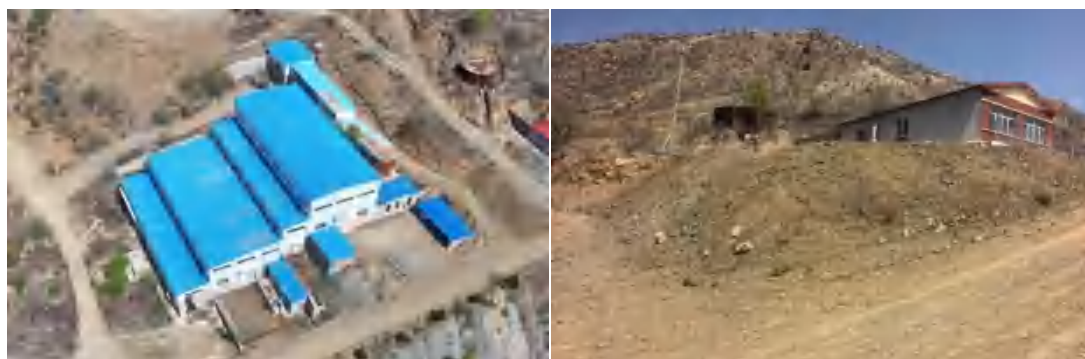
照片 3-3 选矿工业场地及北侧切坡东部
