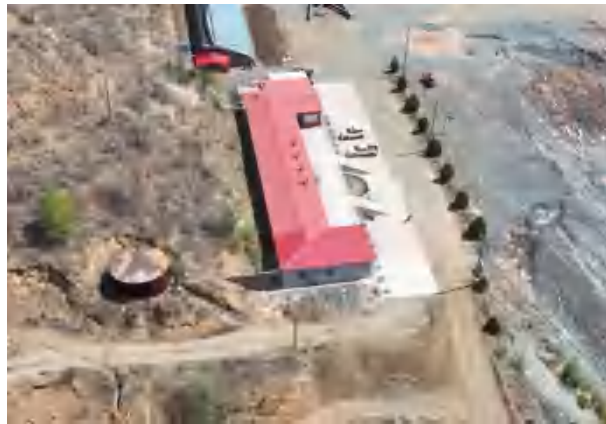
照片 3-4 办公生活区及北侧切坡
