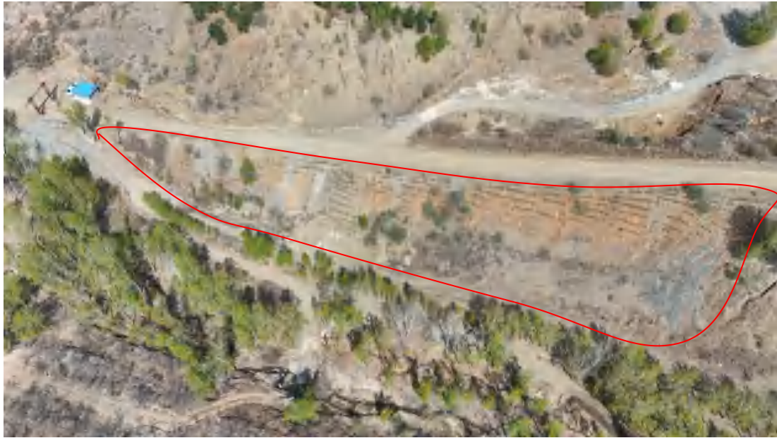
照片4-5 矿区道路堆坡
