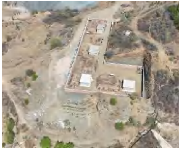
照片3-10 炸药库及雷管库
