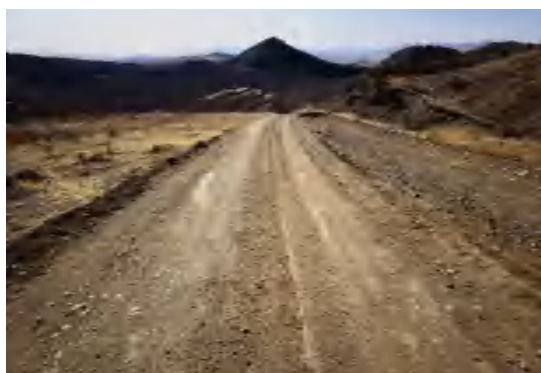
照片3-12 矿区道路
