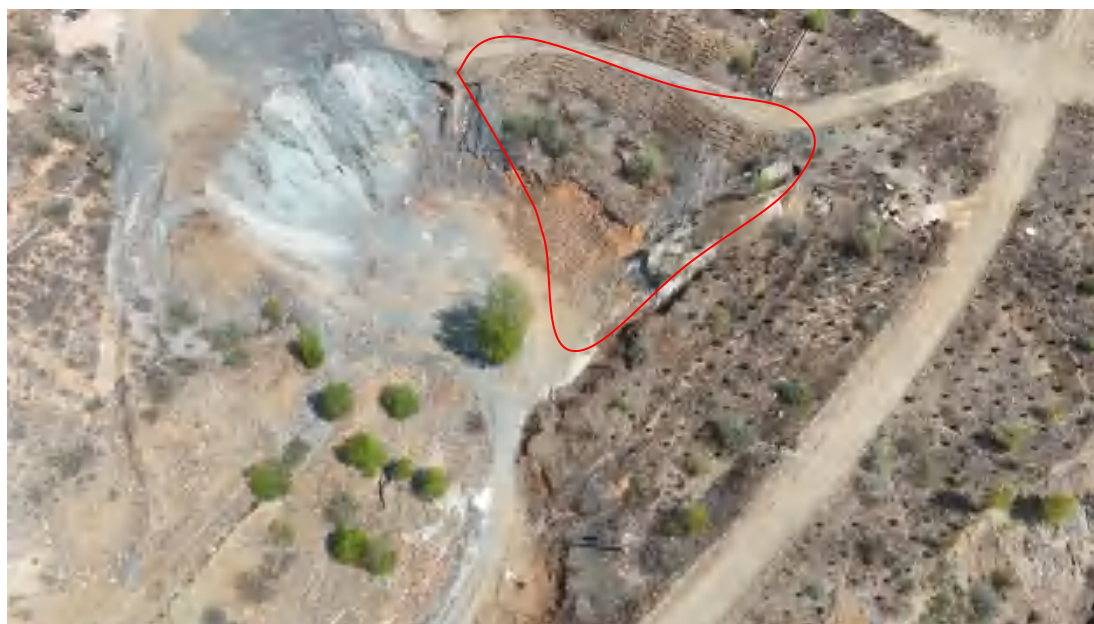
照片4-4 选矿工业场地西侧边坡、XJ废石场南东侧边坡
