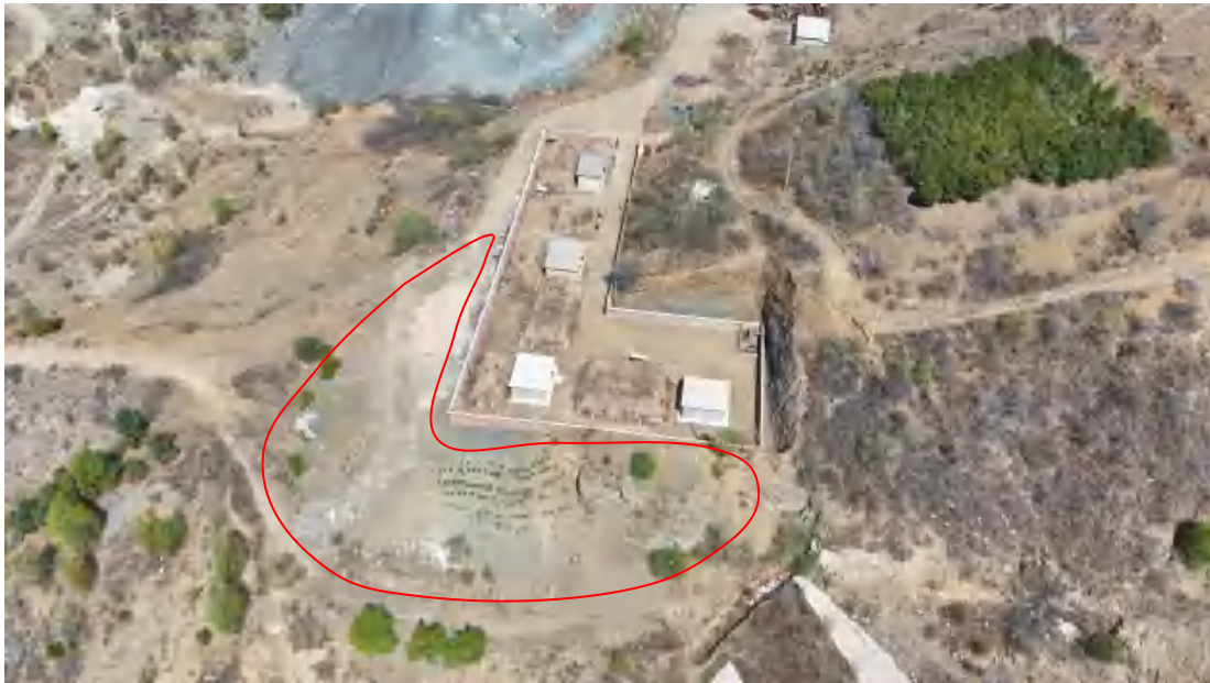
照片4-6 雷管库炸药路东侧边坡
