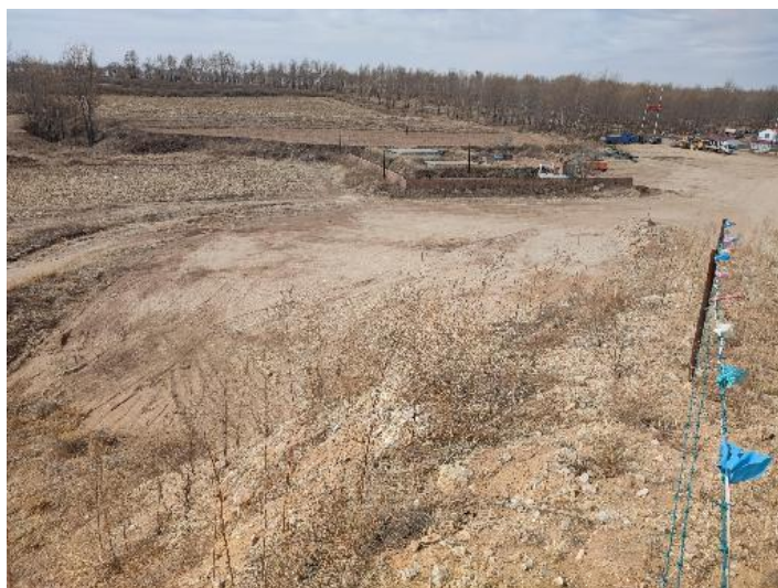
照片2-4 矿山清运完成后的8号料堆区域
