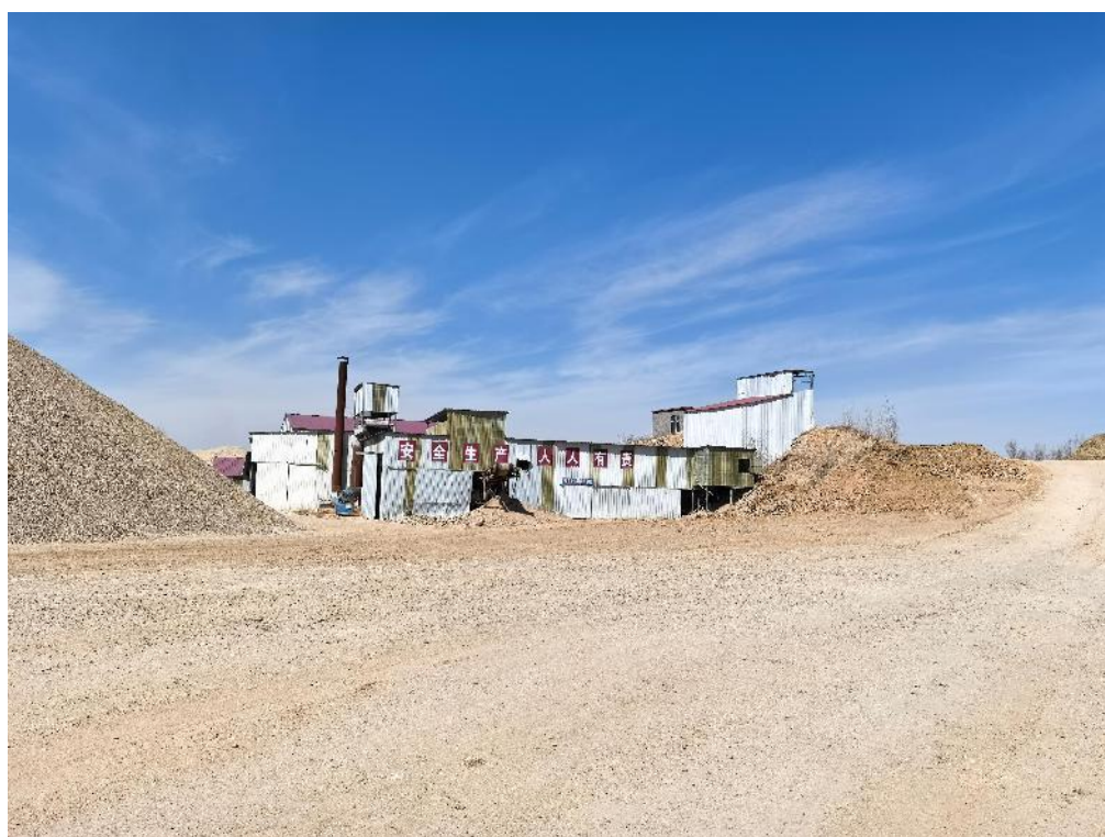
照片 4-6 矿山改造后的碎石加工场地
