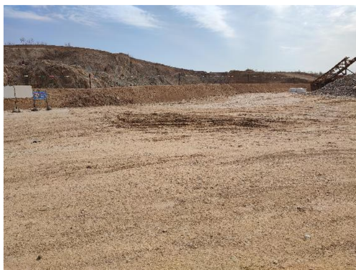
照片2-5 矿山清运完成后的7号料堆区域
