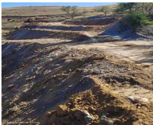
照片 4-1 矿山治理效果照片(原 7 号废弃场地修坡)
