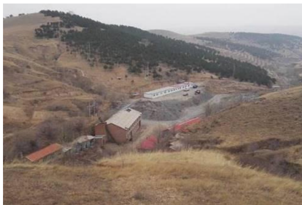
照片 3-3 厂房和平硐工业场地休息区
