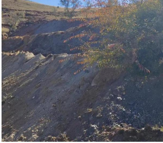
照片4-2 矿山治理效果照片（原7号废弃场地修坡）
