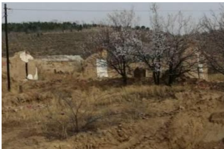
照片1-8 废弃房屋治理效果
