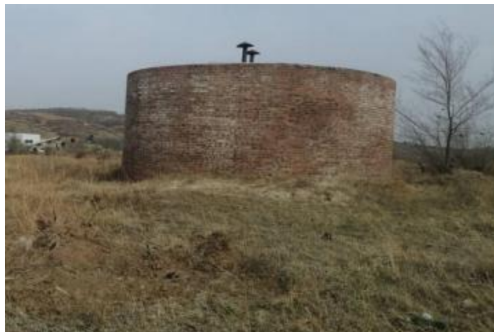
照片1-7 废弃蓄水池
