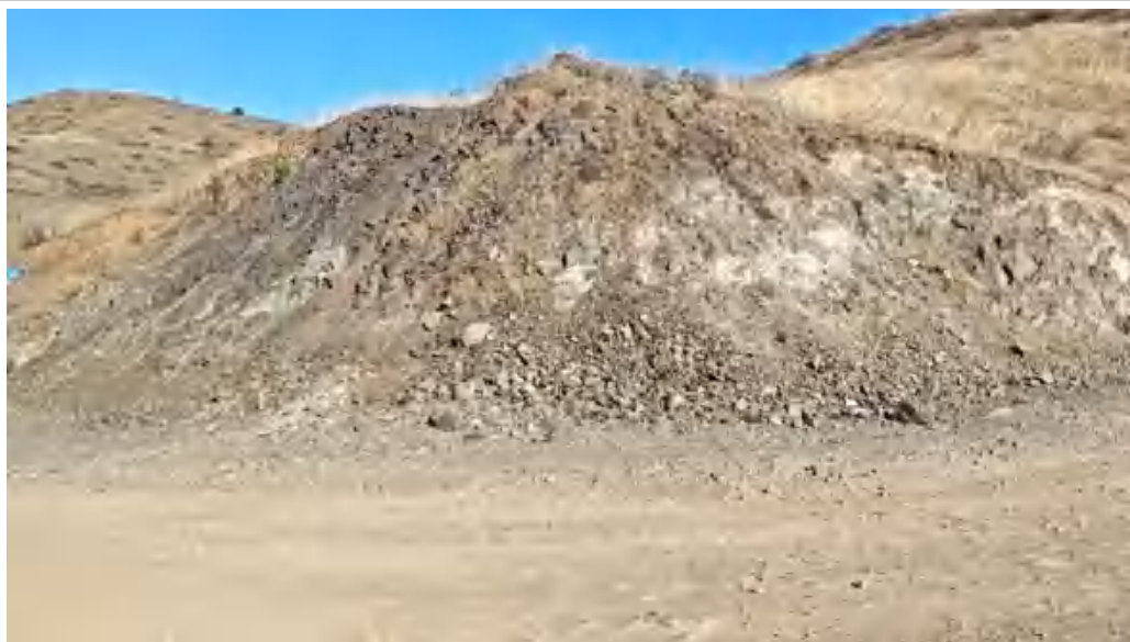
照片 4-30 道路切坡
