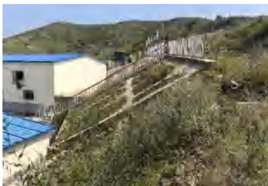
照片 4-4 SJ1 工业场地切坡 1（已框格护坡） 照片 4-5 SJ1 工业场地切坡切坡 2
