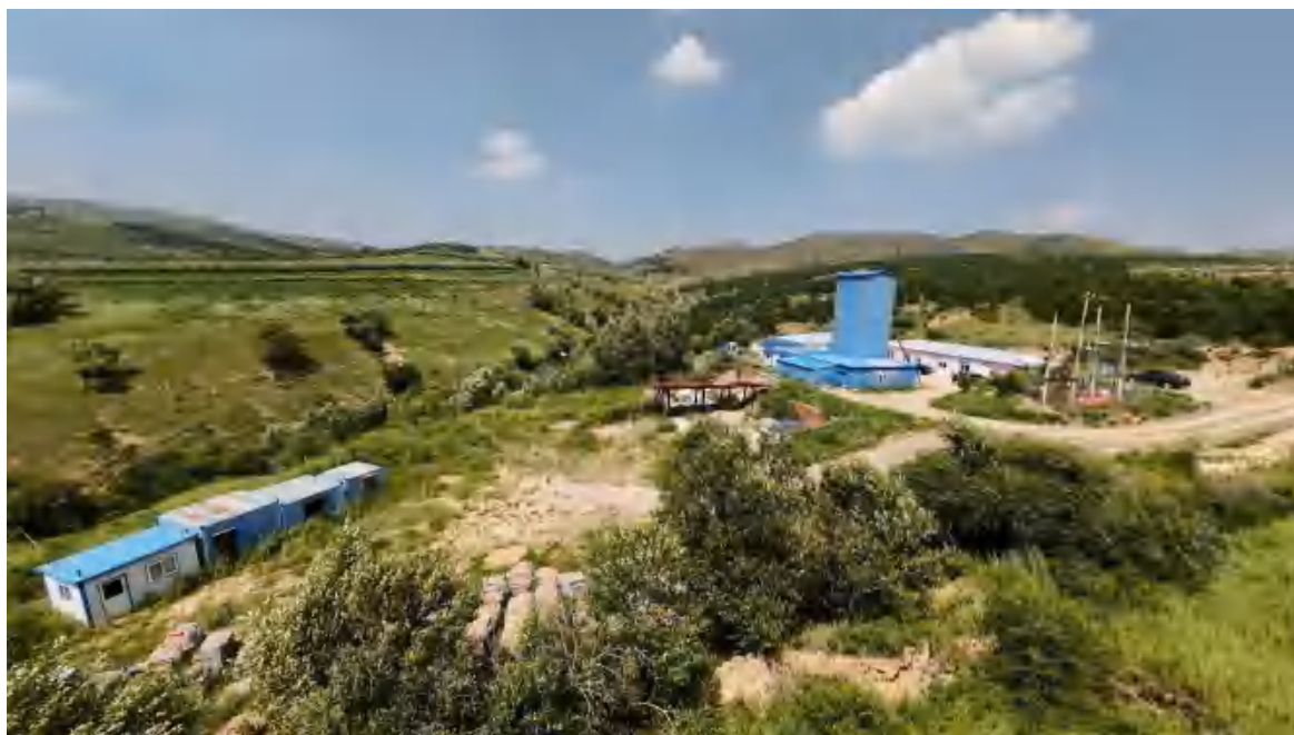
照片 4-15 SJ3 工业场地全景
