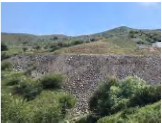
照片 4-10 场地堆坡
