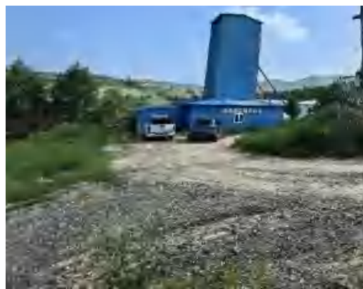
照片 4-17 SJ3 工业场地内竖井井口
