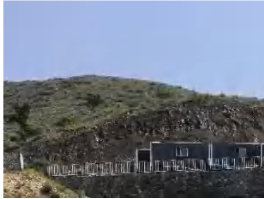
照片 4-2 休息室切坡及浆砌石护坡
