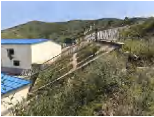
照片 4-1 井口场地框格护坡
