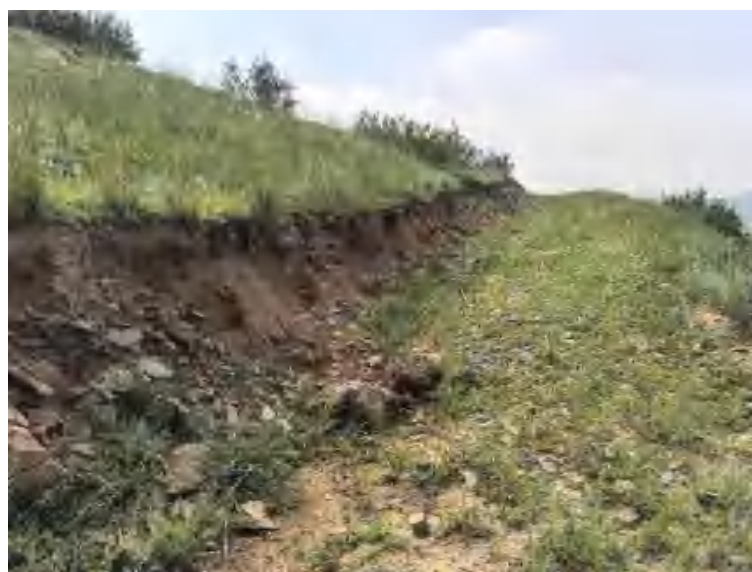
照片 4-29 矿区道路
