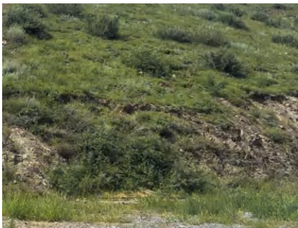
照片 4-19 生活区切坡
