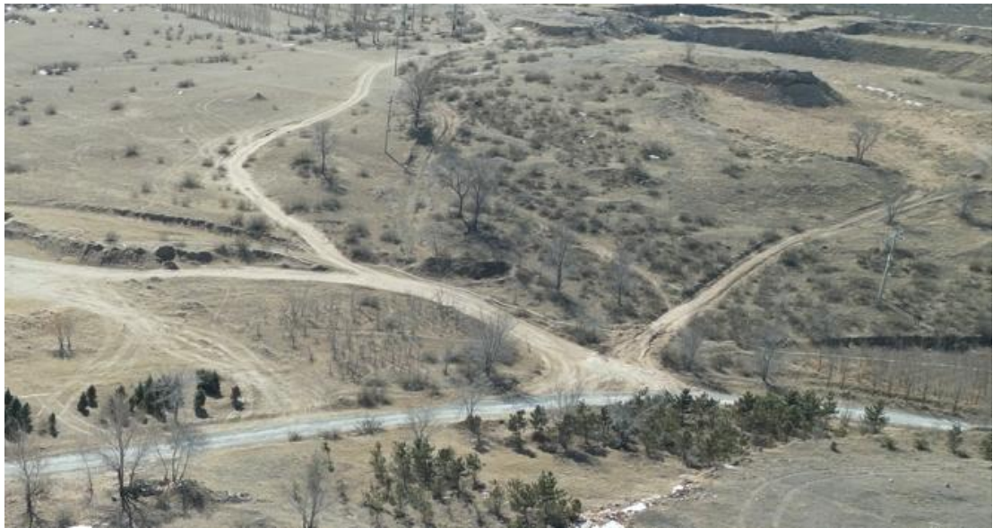
照片4-11 矿区道路（局部）
