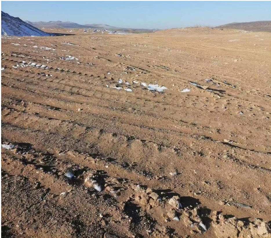
照片 4-2 3#露天采坑
