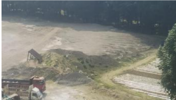
照片2-1 已清运的部分表土堆
