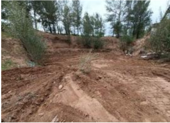
照片2-14 2022年治理SJ4工业场地内废渣
