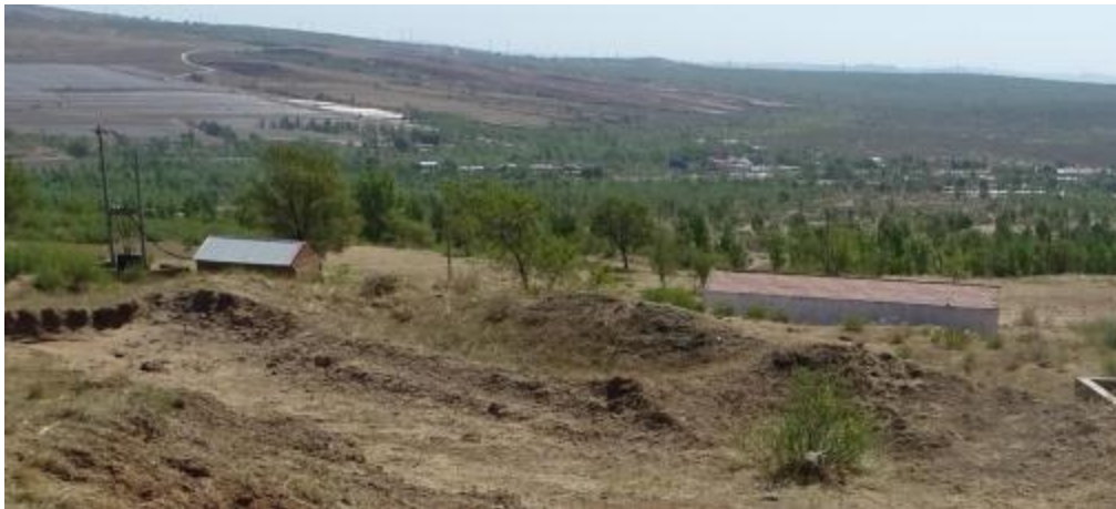
照片 4-15 配电室（左）、仓库（右）
