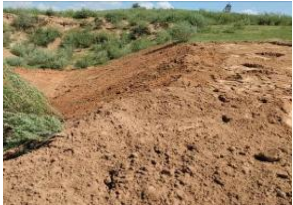
照片2-12 2022年治理探坑（探坑4）
