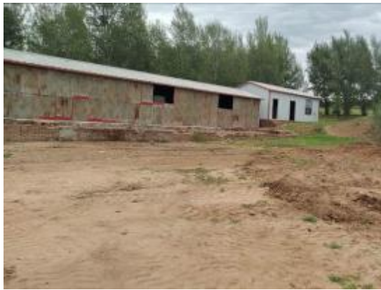
照片2-16 2023年治理SJ4工业场地内建筑
