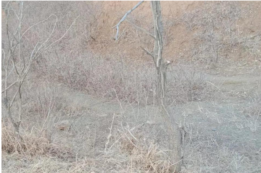
照片2-12 治理后矿区道路
