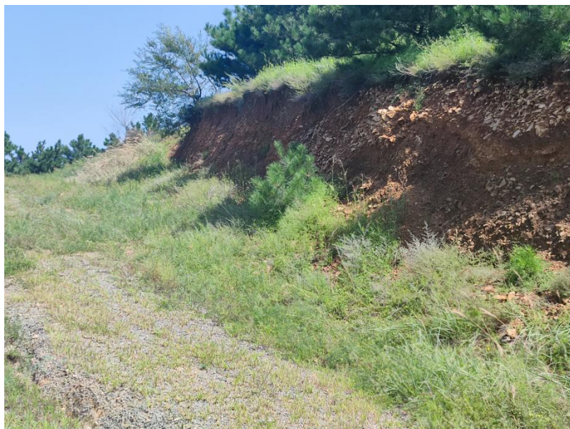
照片4-13 矿区道路及切坡
