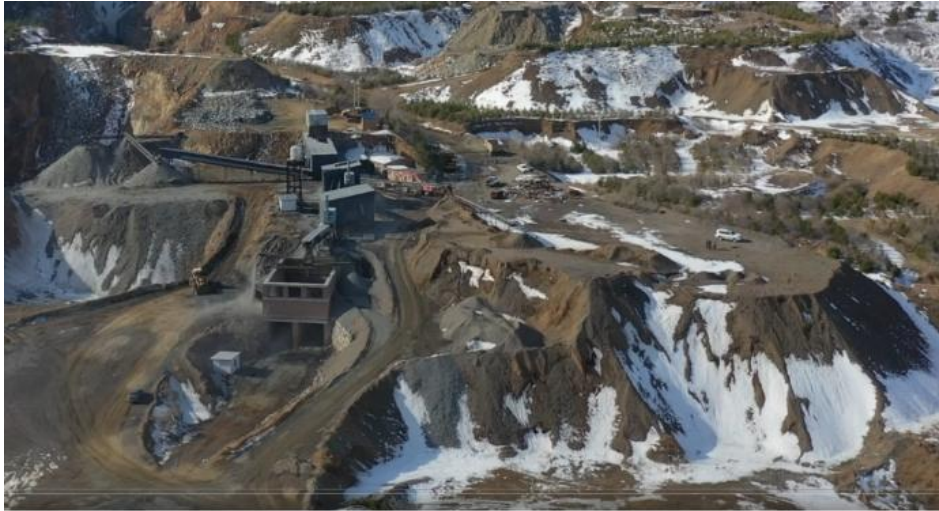
照片 4-12 破碎区（东侧视角）
