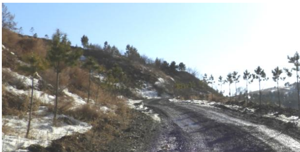
照片 4-18 矿区道路(两侧栽植松树路段)
