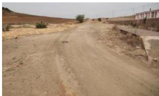
照片3-33矿区道路
