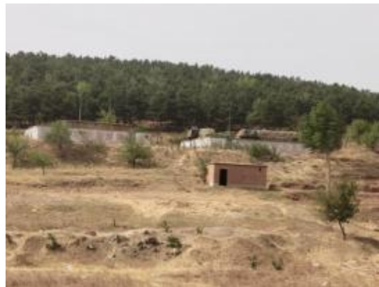
照片4-27炸药库及雷管库
