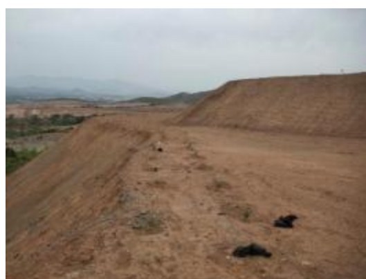
照片4-11废石场1西侧边坡
