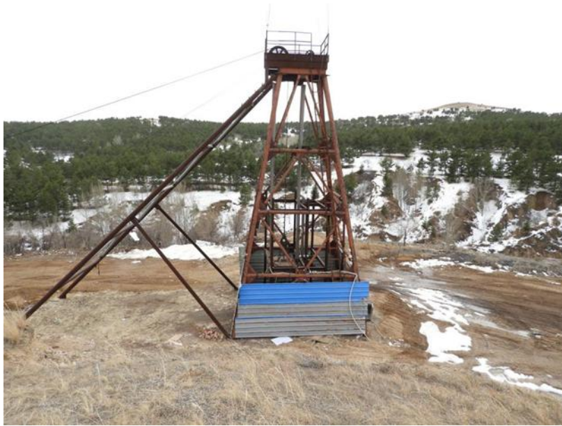
照片 4-8 SJ6 工业场地竖井照片
