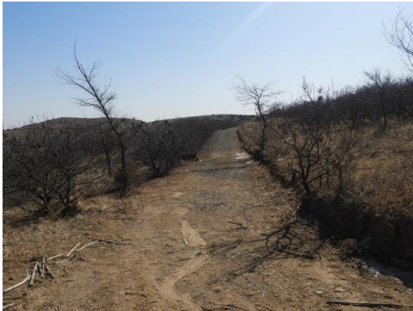
照片 4-39 矿区道路
