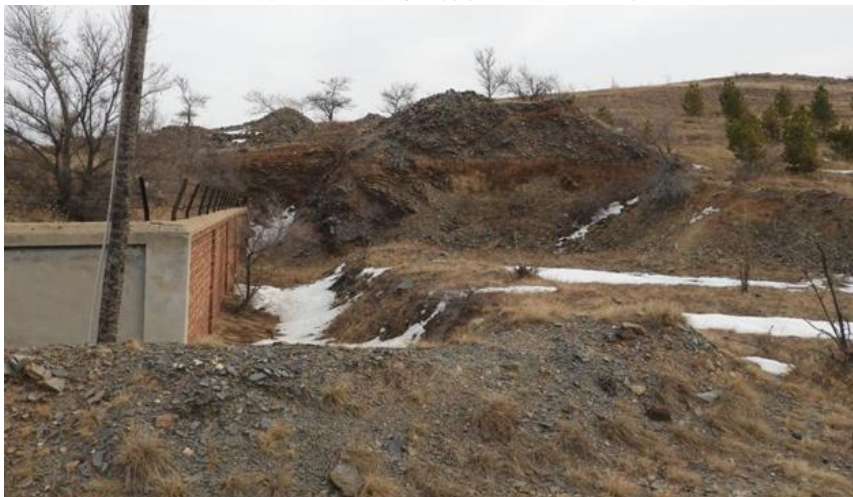
照片 4-38 炸药库 2 场地切坡照片
