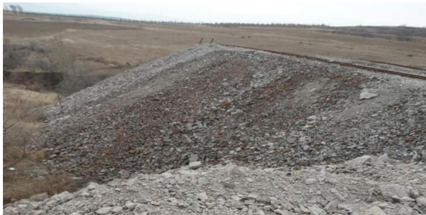
照片 4-2 SJ1 废石堆放场
