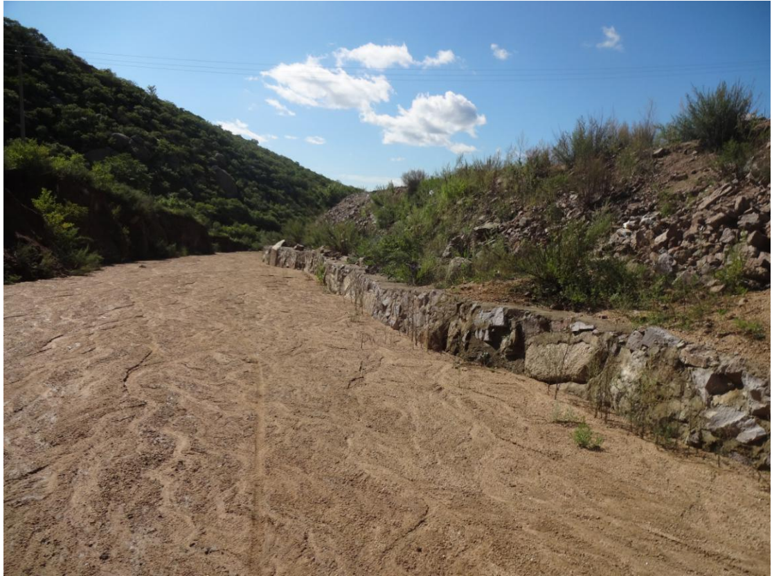
照片2-1 拦挡墙治理效果
