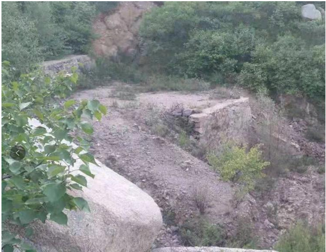
照片2-2 拦挡墙治理效果
