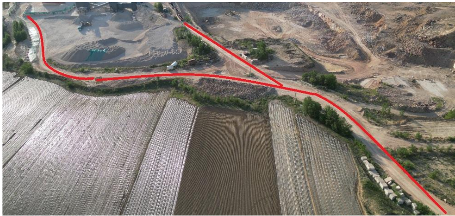
照片 4-4 矿区道路
