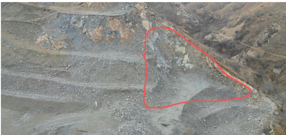
照片 5-2 治理场地清理的石方量垫坡位置
