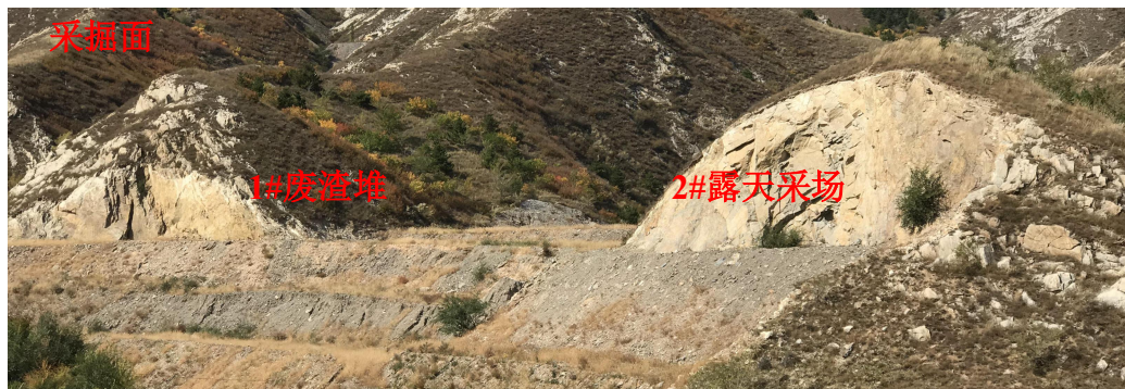
照片 2-2 采掘面、1#废渣堆、2#露天采场
