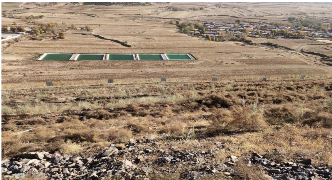
照片 4-1 毛头山矿区已完成的 1#浸矿堆（1-2 浸矿堆）治理效果照片
