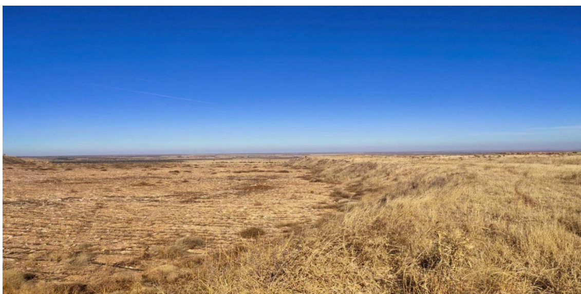
照片 4-2 废弃平硐边坡治理效果照片
