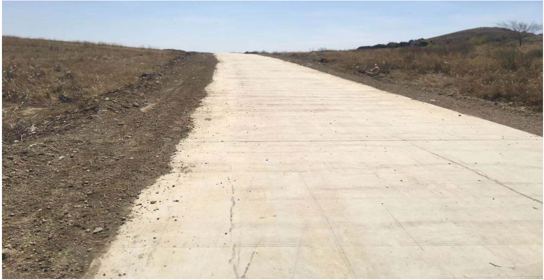
照片3-5 矿区道路照片
