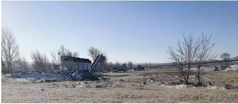
照片4-13 搅拌站（治理中）
